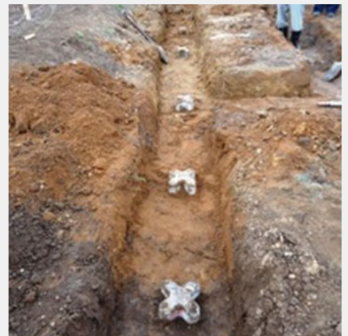
Xパイル施工完了
