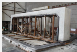
④型枠開放
