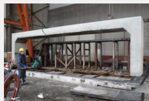
⑤脱型・吊上
