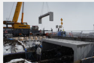
⑨施工状況
