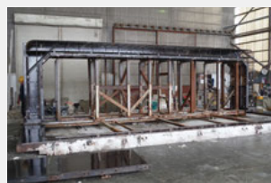
②鉄筋設置
