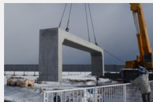
⑧据付開始
