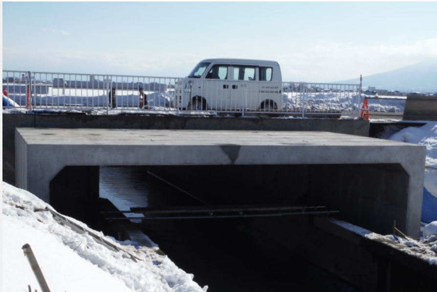
⑩施工完了
