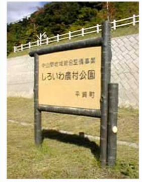
写真中の文字パネル部分が木目仕上 柱、横木部分が樹皮(桜)仕上
