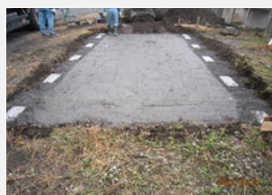
①基礎ブロック敷設
