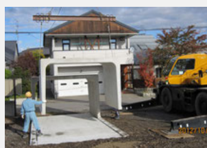
④クレーンによる敷設
