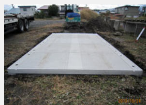
②床板ブロック敷設
