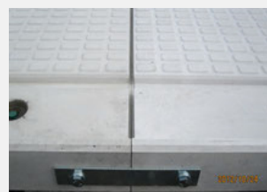
③床板ジョイント金具とノンスリップの凹凸模様あり
